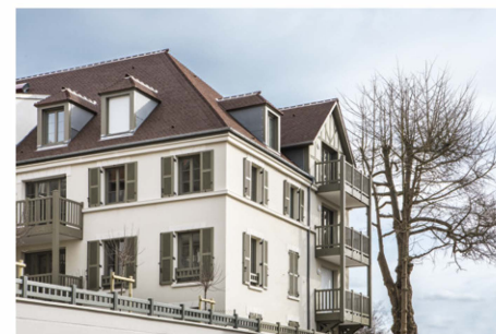
Résidence Andersen : 65 logements 86 rue du Général de Gaulle - Trouville-sur-Mer ARCAS Architecte - livrée en février 2020
