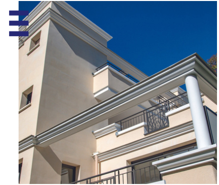
Conception des façades pour éviter les coulures
