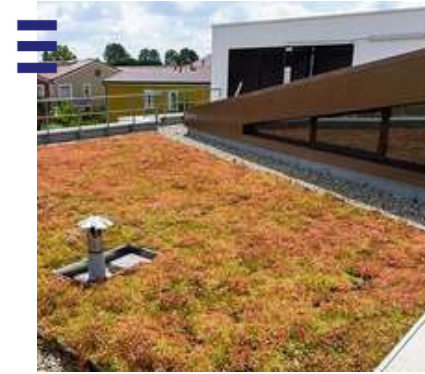
Végétalisation pour une biodiversité positive en toiture
