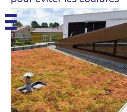
Végétalisation pour une biodiversité positive en toiture
