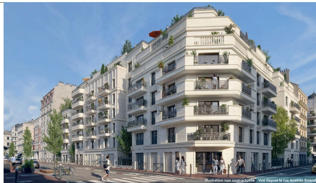
Illustration non contractuelle Vue depuis la rue Aristide BRIAND
