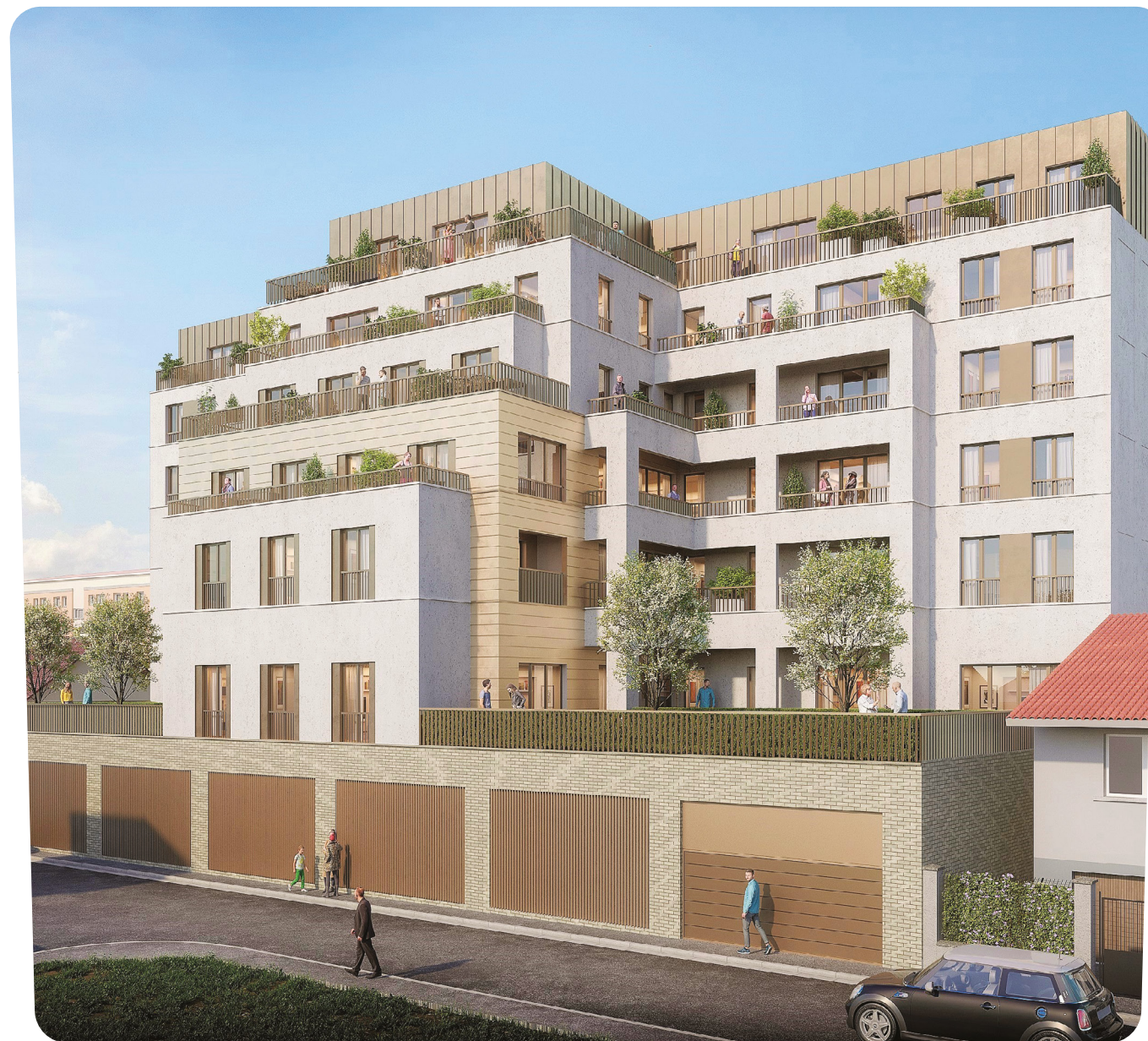
FAÇADE OUEST SUR LA RUE MORIN
